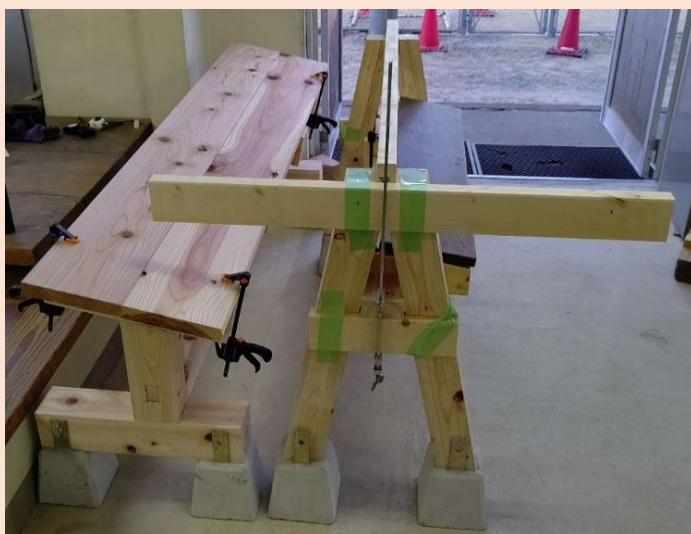
微調整が必要な箇所をチェックしています。
