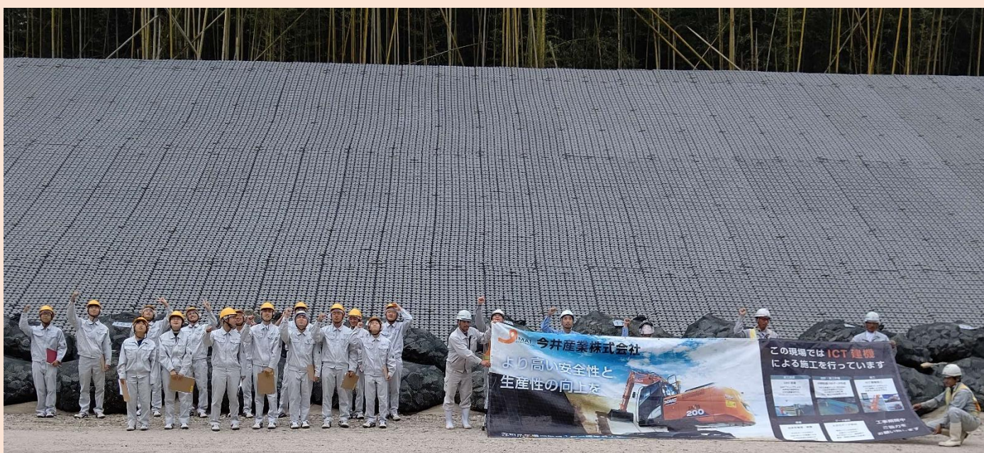
② 江の川大貫地区第1 築堤護岸外工事現場
