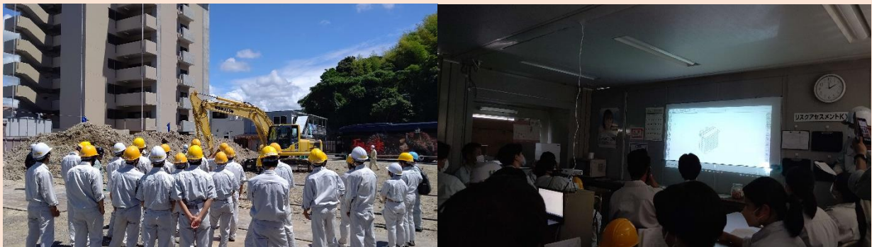
県営住宅浜田中央団地建設現場
