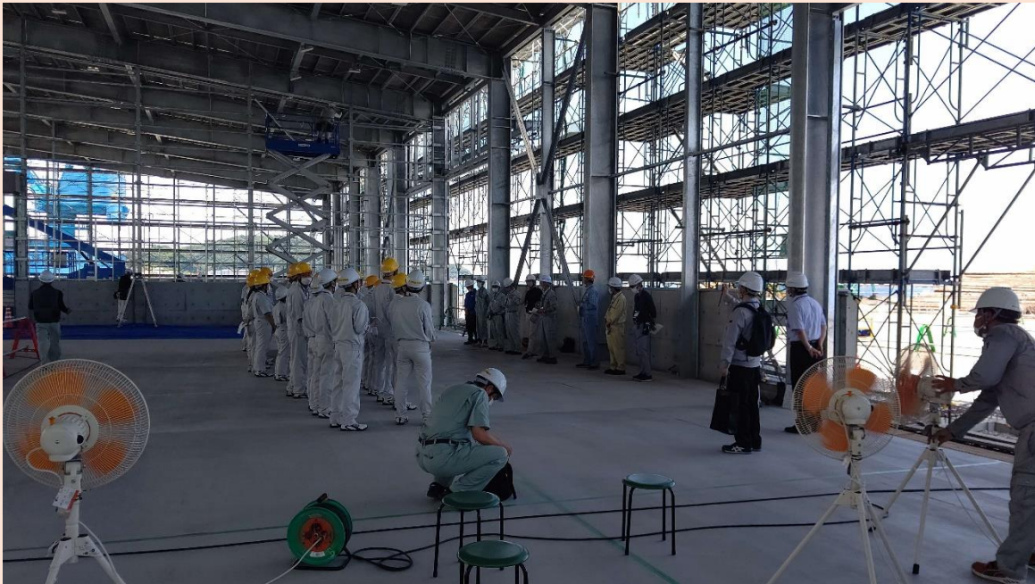
浜田市福井上屋建設現場
