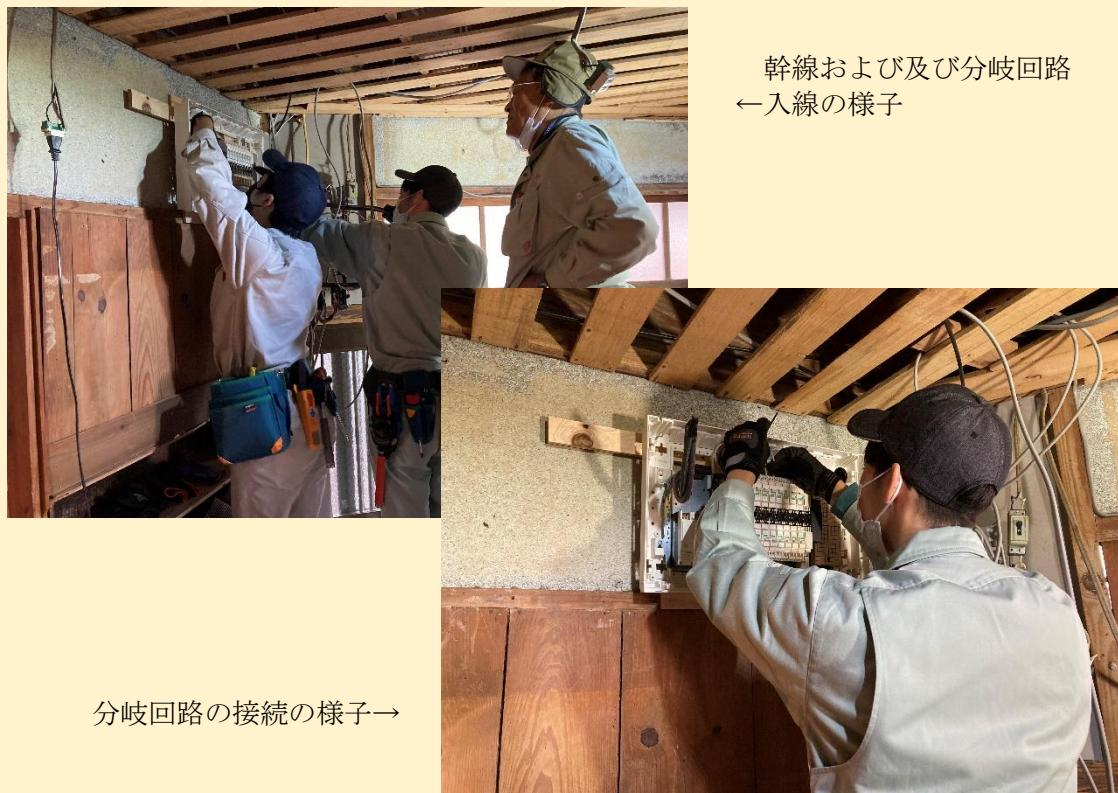
本日は、分電盤取付と幹線の入線、分岐回路の入線と接続を行いました。店舗には分岐回路が多数必要であるため、幹線の容量を大きくしなければなりません。また、既設部分にも正しく供給する必要があり、新設する分電盤の各配線用遮断器に正しく接続が行えるよう、こまめな確認が必要な作業となりました。
