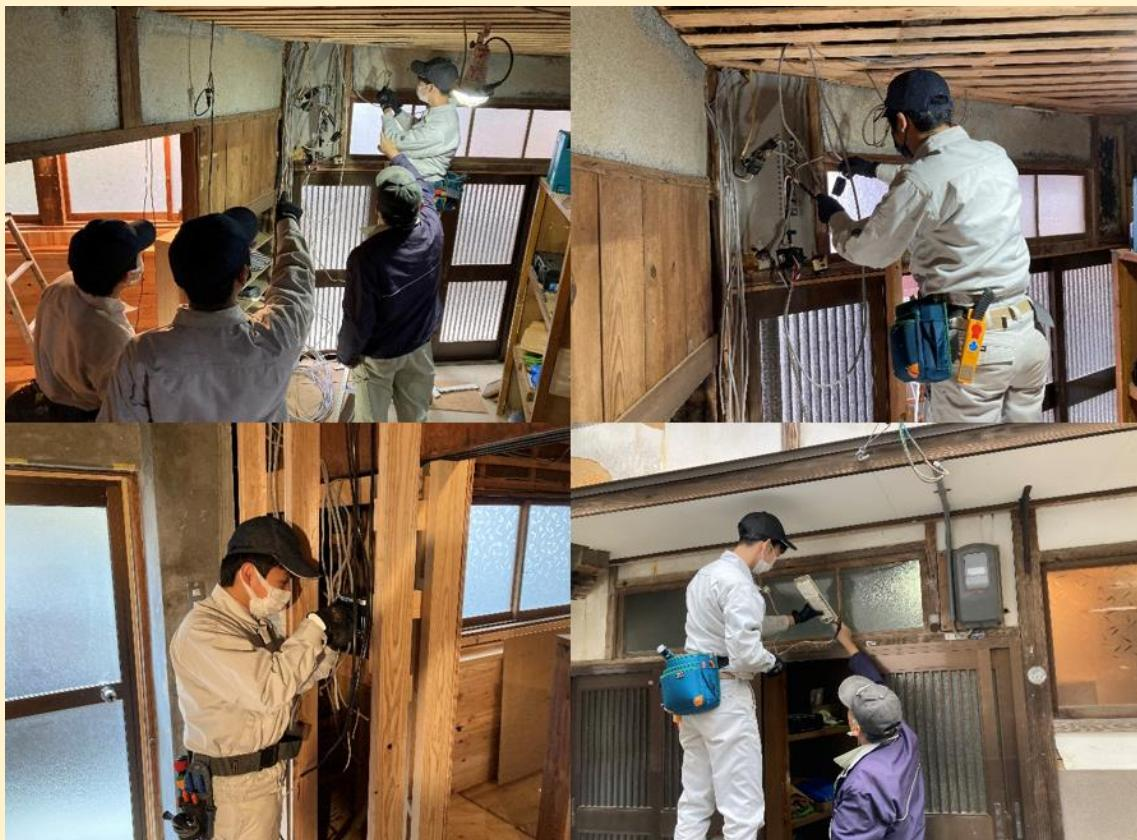
本日は、トイレ・手洗い部分の器具取付工事と分電盤取付の下準備を行いました。分電盤の周辺は通常よりも太いケーブルが多数集合し、既設との取り合いが発生するため扱いが難しく、前回に続いて厳しい作業となりました。
