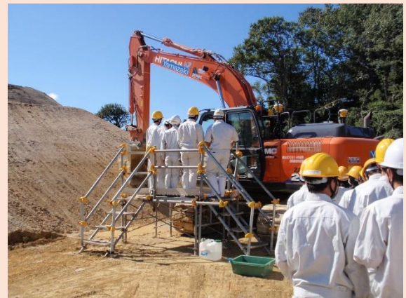
② 福光・浅利道路福光地区改良第1工事現場
