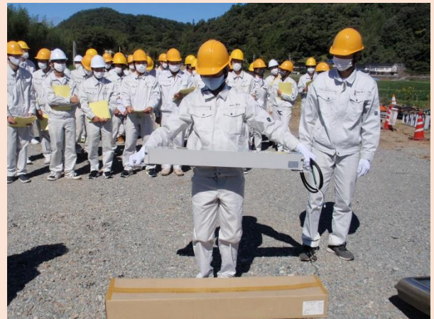
③ 江の川八神地区第1築堤護岸他工事現場
