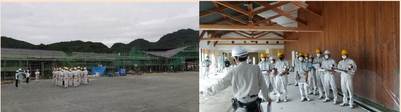
仁摩 道の駅建設現場
