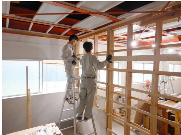
図6 間仕切り壁の施工
