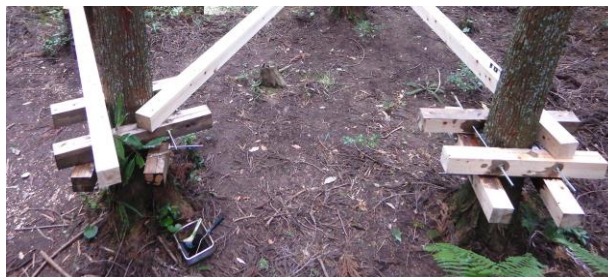
図29 サンドイッチ工法
