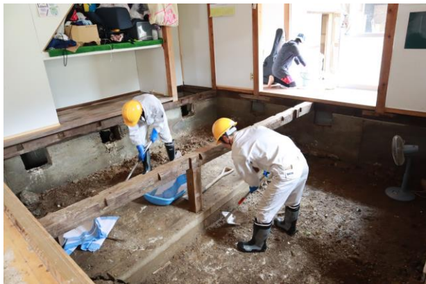
図1 床下の泥の撤去
