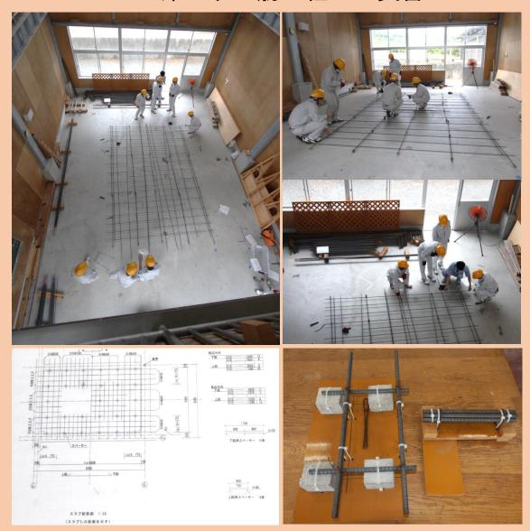
令和2年6月、建築・電気科3年 建築コースでは、床スラブ筋の組立て実習を行っています。
