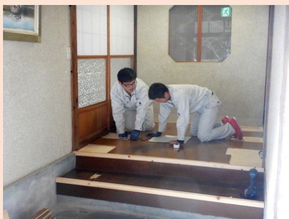
玄関床のリフォーム風景
