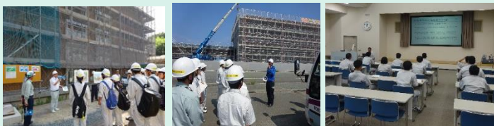
大田市立病院新築現場
