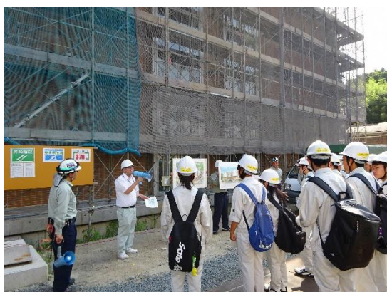
大田市立病院建設現場
