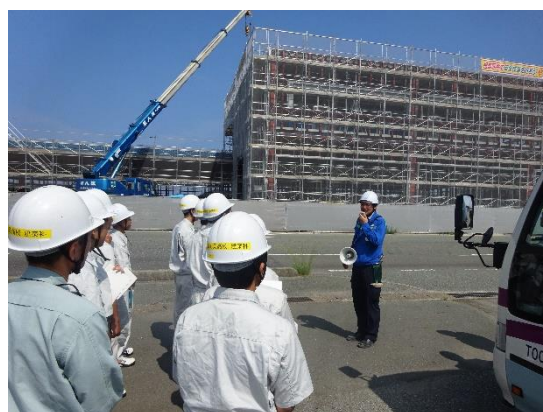
浜田漁港荷捌き所建設現場
