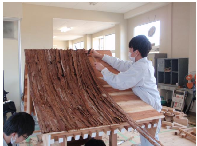
ひわだ (野地板を張り、桧皮を葺く)
