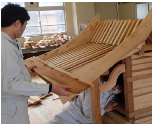
たるき はふいた (垂木、破風板取り付け後、野地板を張る)
