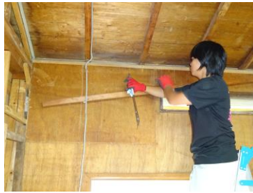
解体（解体工事）
