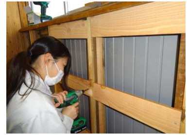
壁下地取り付け（木工事）
