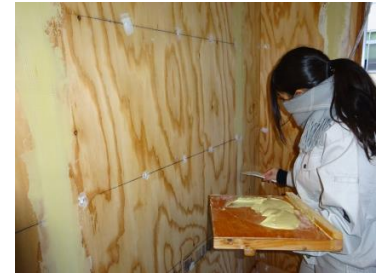
パテ処理（塗装工事）
