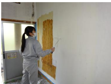
上塗り（塗装工事）
