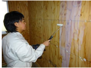
アク止め塗装（塗装工事）
