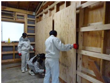
合板張り（木工事）
