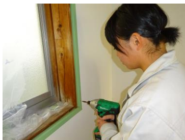
額縁取り付け（雑工事）
