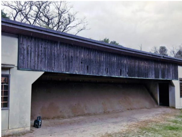
① 施工前の様子
