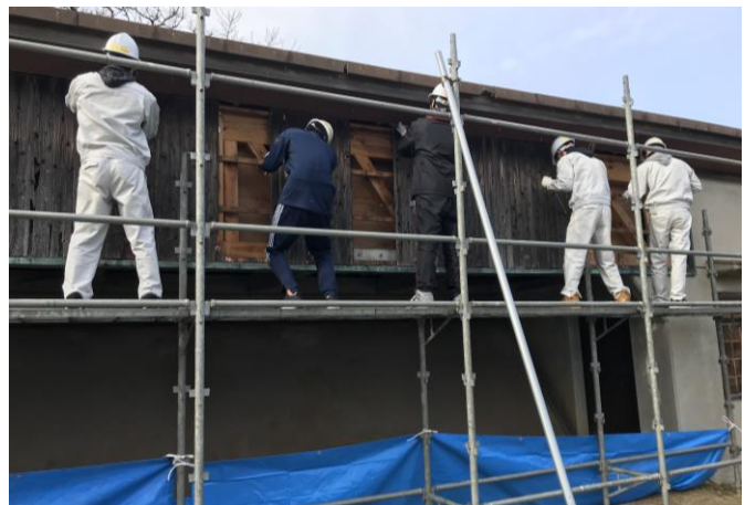
④ 古い壁をはがして
